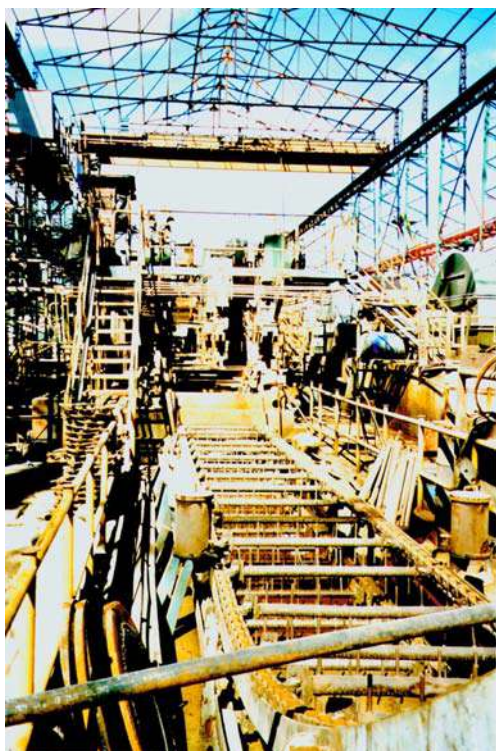
Foto 9: Vista interna da Destilaria Pindorama (em manutenção)
