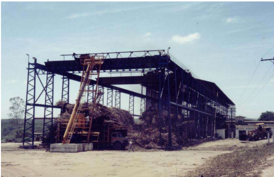
Foto 29: Vista externa da Destilaria Pindorama (em operação)
