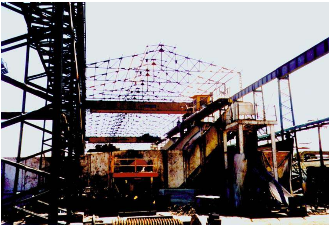
Foto 6: Vista interna da Destilaria Pindorama (em manutenção)
