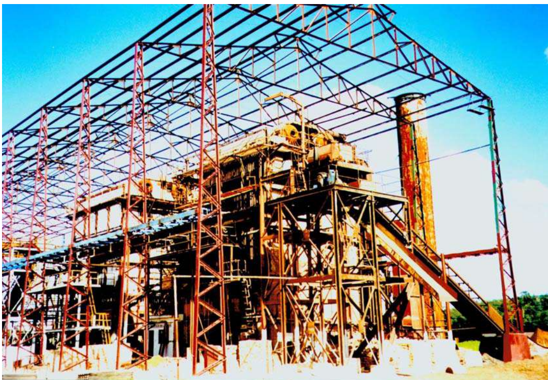
Foto 12: Vista da caldeira – Destilaria Pindorama (em manutenção)
