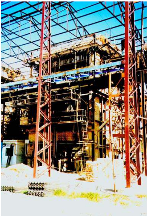
Foto 11: Vista da caldeira – Destilaria Pindorama (em manutenção)
