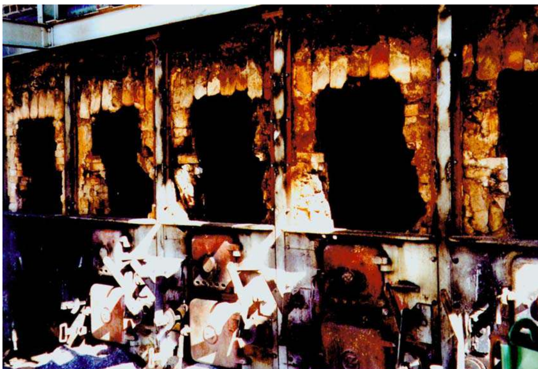
Foto 10: Vista da caldeira – Destilaria Pindorama (em manutenção)
