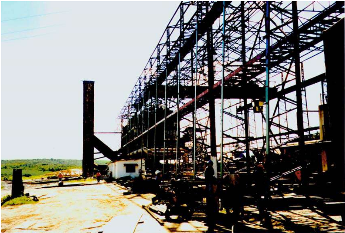
Foto 7: Vista lateral da Destilaria Pindorama (em manutenção)
