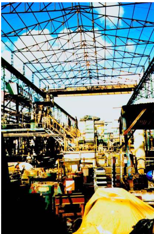
Foto 8: Vista interna da Destilaria Pindorama (em manutenção)
