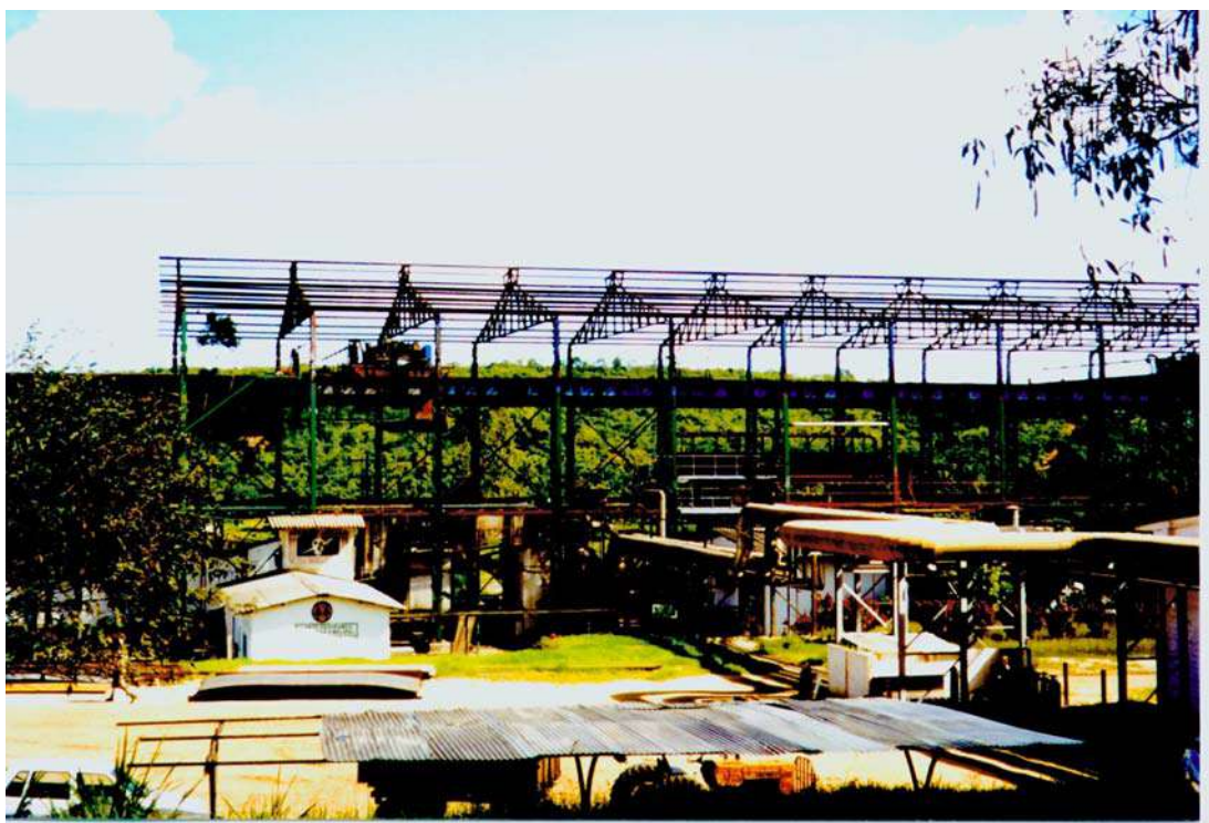
Foto 2: Vista das instalações da Destilaria Pindorama (em manutenção)
